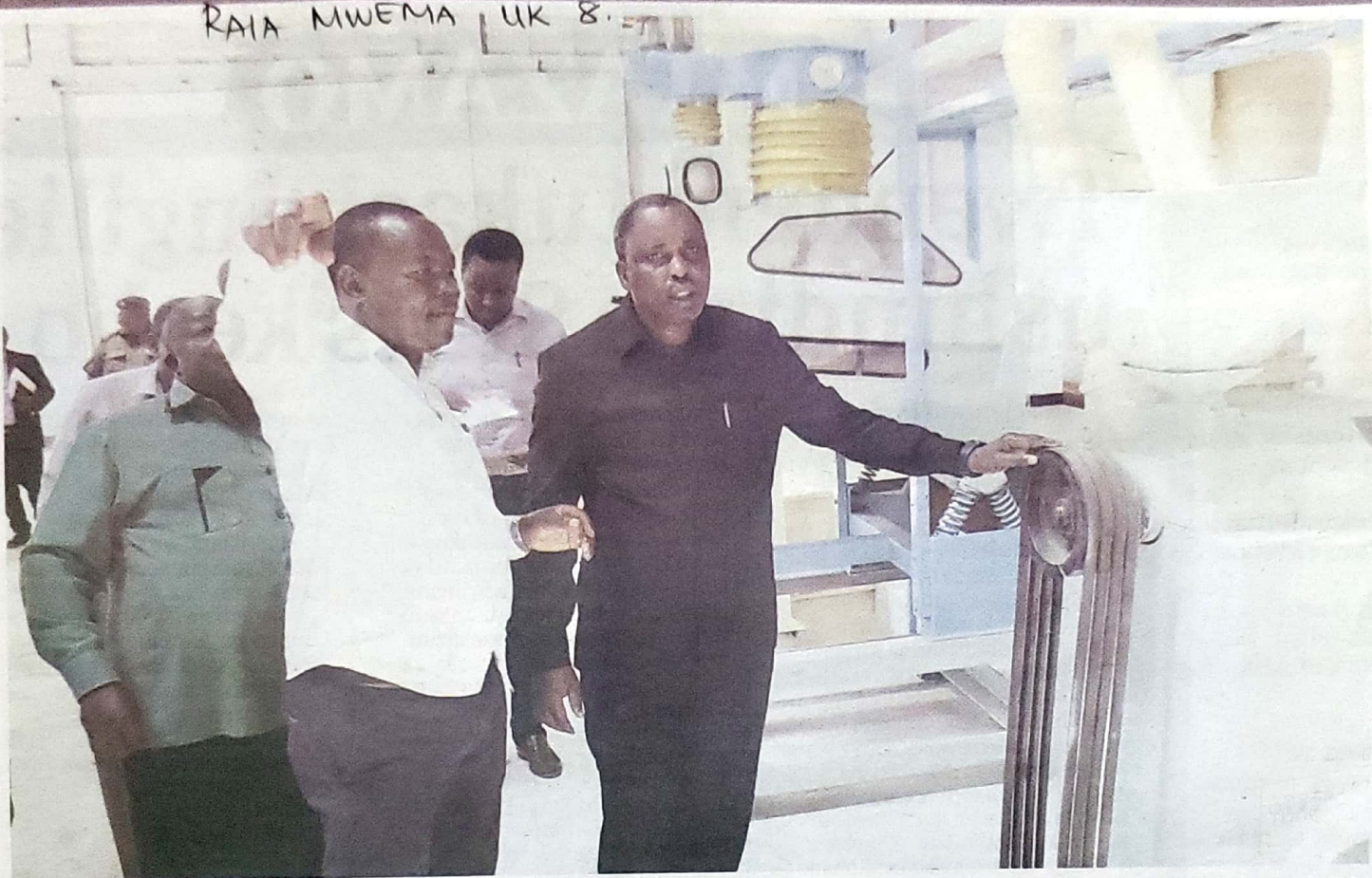
Mkurugenzi wa Kampuni ya Kahama Fresh, Josam Mtangeki (kushoto) akitoa maelezo kwa Waziri wa Mifugo na Uvuvi, Mashimba Ndaki, kuhusu mitambo iliyofungwa katika kiwanda cha kuchakata maziwa na chakula cha mifugo cha kamouni hiyo namna itakavyofanya kazi, alipokagua maendeleo ya kiwanda hicho wilayani Karagwe, Kagera juzi. (Na Mpiga Picha Wetu).
